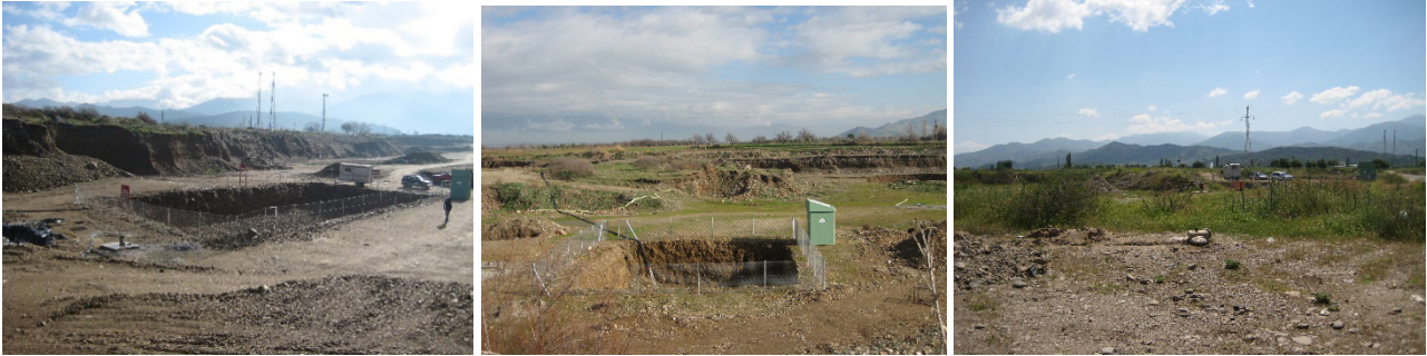
Şekil 2.4 DSİ tarafından Tire çevresinde yapılan yeraltısuyu depolama çalışmaları
