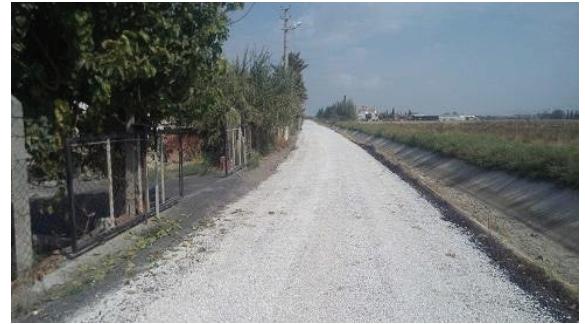
Çiğli İlçesi Kalkıç Mahallesi Sathi Kaplama Çalışmaları
