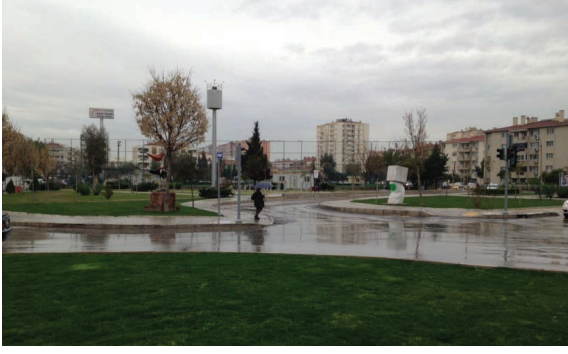
Atakent Asfalt Kaplaması Bakım ve Tadilatı
