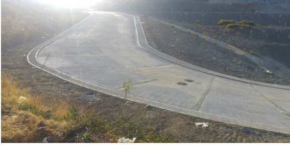
Narlıdere Musa Anter Sokak Altı Beton Yol Yapılması İşi
