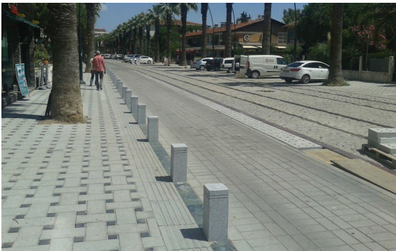
Karşıyaka İlçesi Tramvay Hattı Cengiz Topel Caddesi Granit Taş Yapılması İşi
