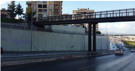
Çiğli İlçesi Esentepe Mahallesi 8809 Sokak Yaya Üst Geçidi
