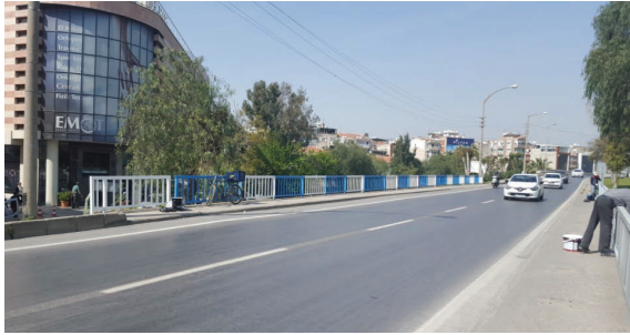
Muhtelif Yaya Üst Geçitleri, Karayolu Üst ve Alt Geçitleri İle Köprülerde Bakım Onarım ve Boya Yapılması
