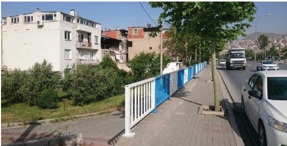
Bayraklı İlçesi Manas Bulvarı Yol Tipi Korkuluk
