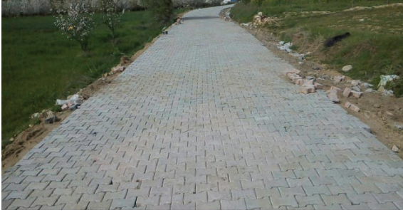
Beydağ-Tire-Ödemiş-Kiraz Bölgesi Parke Döşemesi
