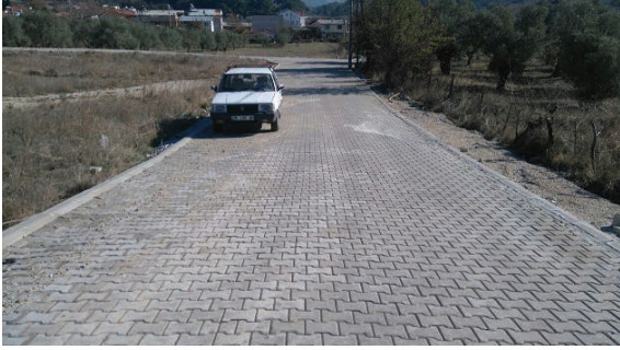
Torbalı, Selçuk Bölgeleri Parke Döşenmesi
