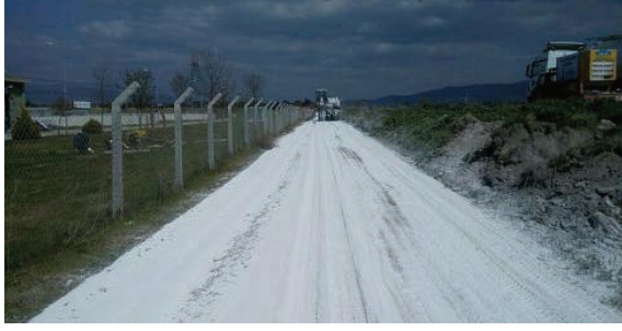
Menemen İlçesi Ova Yolları Kireç Stabilizasyonu Yapılması
