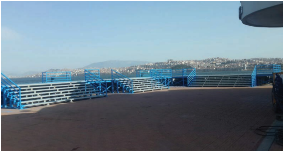
Üçkuyular İskelesi Geçici Yükseltilmiş Yolcu Platformu Yapılması
