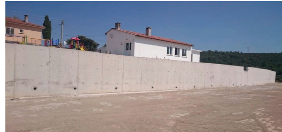
İstinat Duvarı Çalışmaları
