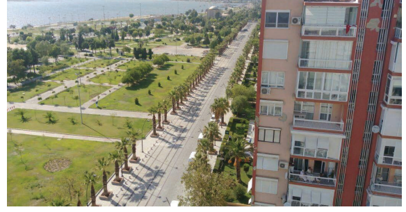
Karşıyaka İlçesi Tramvay Hattı Cengiz Topel Caddesi Granit Taş Yapılması İşi
