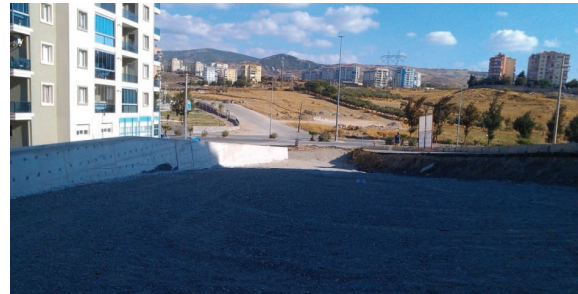
Yol ve Tretuvar Düzenlemesi Yapılması
