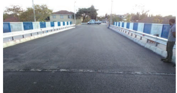
Menderes İlçesi Gölcükler Mahallesi Cumaovası-İstasyon Caddesi Taşıt Köprüsü
