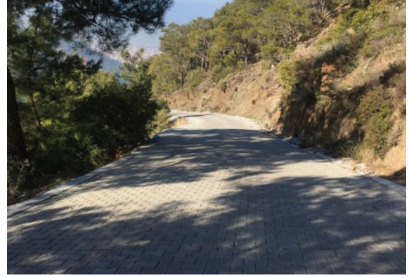
Balçova Teleferik Yolu Kilit Parke Taşı Kaplama
