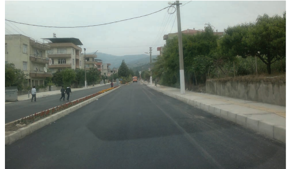
Beydağ İlçesi Kültür Bulvarı Düzenlemesi
