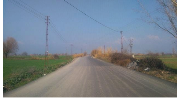
Ödemiş İlçesi Balabanlı Mahallesi Asfalt Serim Çalışmaları
