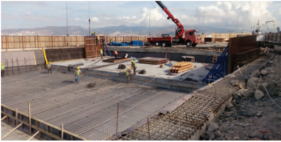
Mustafa Kemal Sahil Bulvarı Küçükyalı İle Karataş Arası Güzergahta Altyapı ve Sanat Yapıları
