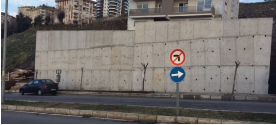
Kuzey Bölgesi Muhtelif Yerlerde İstinat Duvarı
