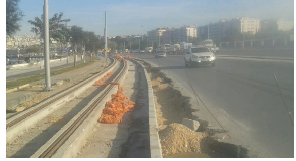
Tramvay Güzergahında Yol ve Tretuvar Düzenlenmesi
