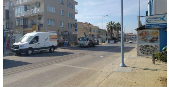
Güzelbahçe İlçesi Mithatpaşa Mahallesi 50 Sokak Kesişimi Butonlu Sinyalizasyon Yapılması İşi
