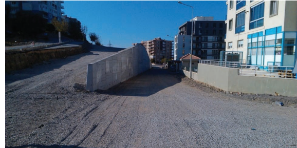
Yol ve Tretuvar Düzenlemesi Yapılması
