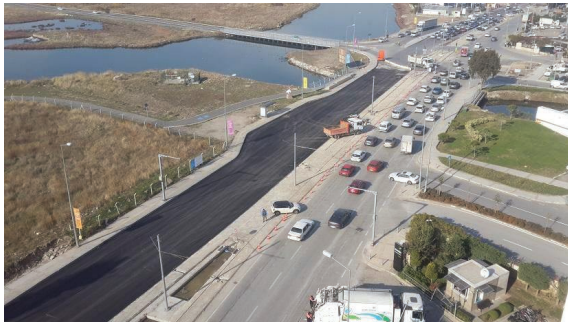
Karşıyaka Çehar Dudayev Bulvarı Tramvay Hattı Asfalt Serim Çalışmaları
