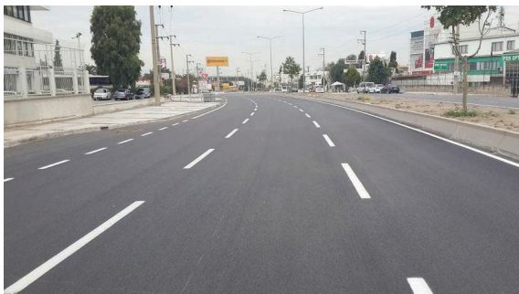
Bornova Kemalpaşa Caddesi Asfalt Serim Çalışmaları
