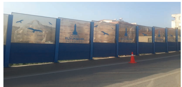
Torbalı ve Tepeköy Karayolu Üst Geçitlerine Ses ve Gürültü Perdesi Yapılması
