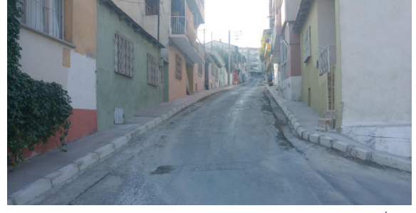
Konak 19 Mayıs Mahallesi Kaldırım Taşı Yapılması İşi
