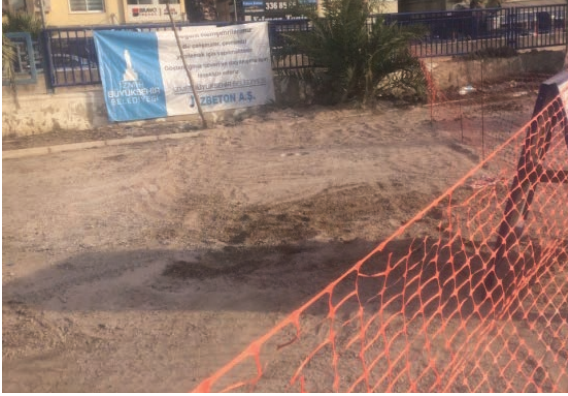
Bostanlı Pompa Odası Bakım ve Tadilatı
