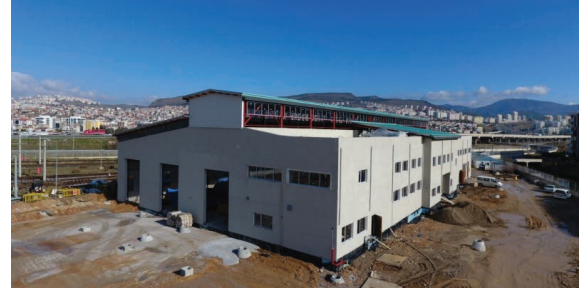
Karşıyaka Tramvayı Atölye Binası
