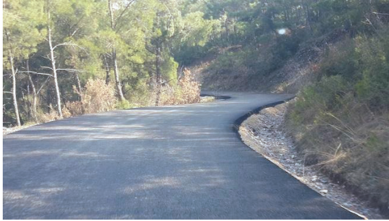
Bornova İlçesi İzmir Manisa Yolu ile Çiçekliköy Mahallesi Arası Asfalt Serim Çalışmaları
