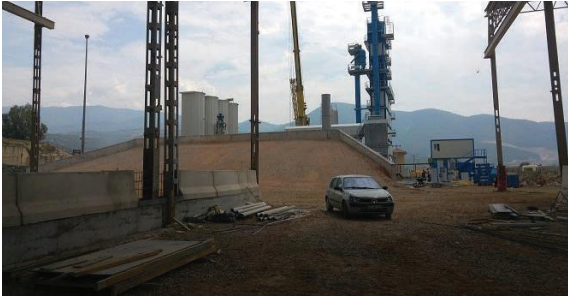
Bornova İlçesi Belkahve Şantiyesi Yeni Plent Tesisi Alanı ve Çevresi Düzenlemesi
