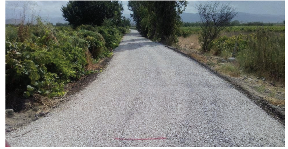
Menemen İlçesi Buruncuk Mahallesi Sathi Kaplama Çalışmaları
