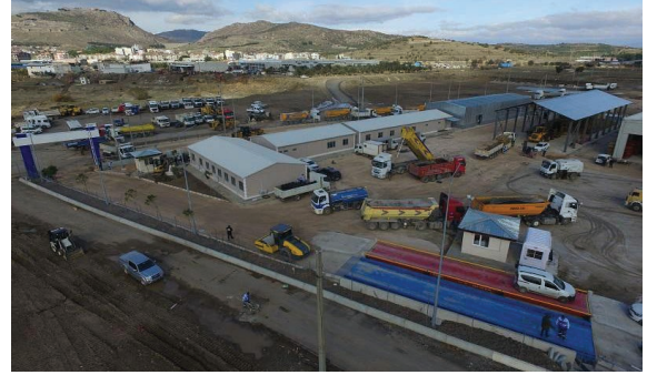
Bergama Bakırçay Şantiyesi Düzenleme
