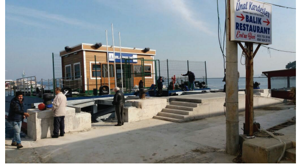
Urla İskelesi Geçici Yükseltilmiş Yolcu Platformu Yapılması
