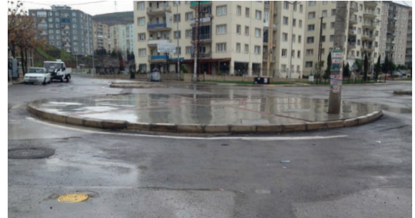
Mimar Sinan Kavşağı Bakım ve Tadilatı
