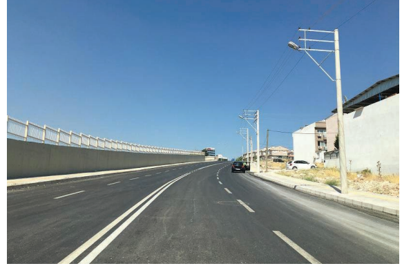
Buca İlçesi 6 Sokak Asfalt Serim Çalışmaları
