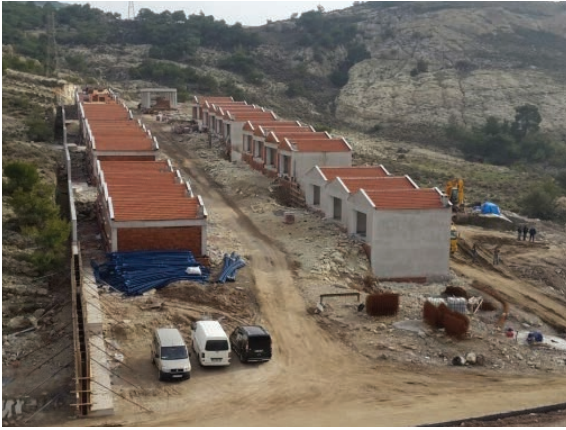
Foça Oto Terminali ve Belediye Dükkanları Yapılması
