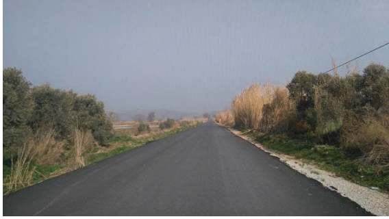
Tire Gökçen Yolu Asfalt Serim Çalışmaları
