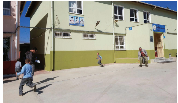
Kiraz Karaburç İlköğretim Okulu Bahçesi Saha Betonu Yapılması
