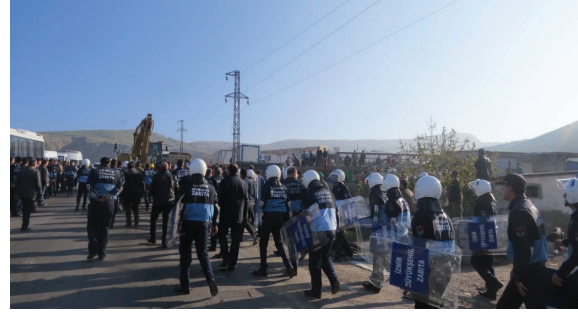
Çevre ve İmar Zabıtası Görevlileri Tarafından Yapılan Yıkım Çalışmaları
