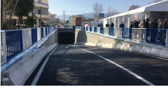
Torbalı İlçesi 4543 Sokak ile 3677 Sokak Kesişiminde Taşıt Alt Geçidi
