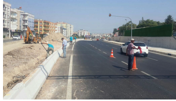
Otokorkuluk Onarımı ve Yapımı ile Tercihli Bordür İmali ve Döşenmesi
