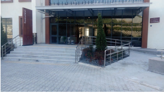
Buca İlçesi Sosyal Yaşam Tesisi İçi Granit Parke ve Kaldırımı
