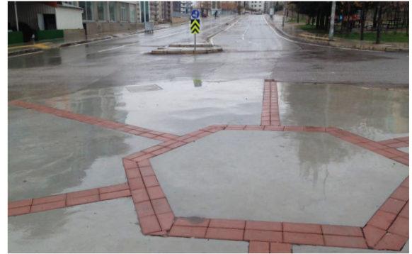
Mimar Sinan Kavşağı Bakım ve Tadilatı
