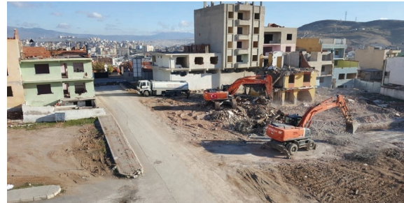
Uzundere Kentsel Dönüşüm Projesi 1. Etap Yapıların Yıkımı
