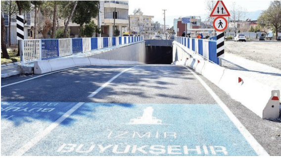
Torbalı İlçesi 4543 Sokak ile 3677 Sokak Kesişiminde Taşıt Alt Geçidi
