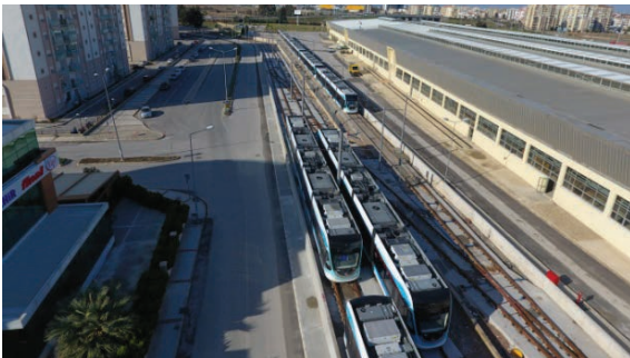
Karşıyaka Tramvayı Depo Sahası
