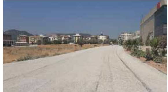
Kemalpaşa İlçesi 9081 Sokak Sanayi Sitesi İçi Sathi Kaplama Çalışması
