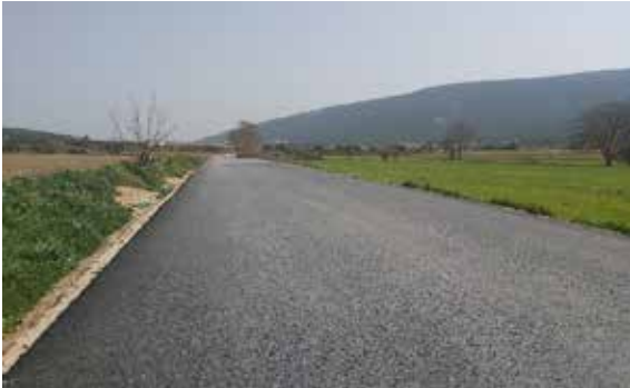
Tire Kurşak - Yenioba Arası Asfalt Serim Çalışması
