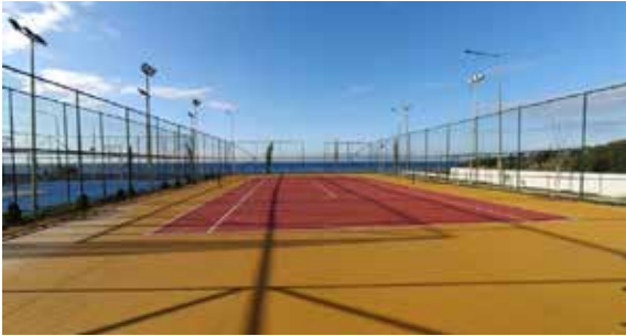
Özdere Çok Amaçlı Hizmet Üniteleri Yapılması İkmal İnşaatı
