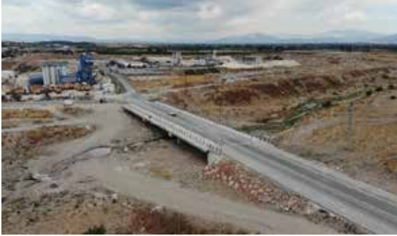
Ilıca Deresi Üzeri Karayolu Köprüsü
