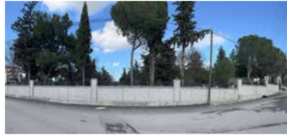
Seferihisar Merkez Mezarlığın duvar imalatı
