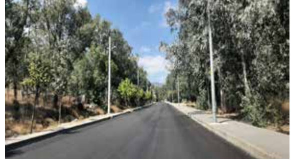
Bayraklı İlçesi Doğançay Mahallesi 7020 Sokak Asfalt Serim Yapılması İşİ
