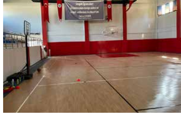
Balçova Belediyesi Kapalı Spor Salonunda Bakım Onarım Yapılması
