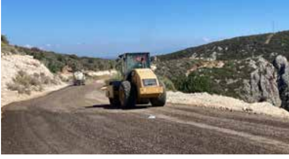
Karaburun Eğlenhoca Mahallesi Tesviyesi İşleri
