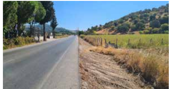
Dikili İlçesi İsmetpaşa Mahallesi Şarmpol Açılması İşi
