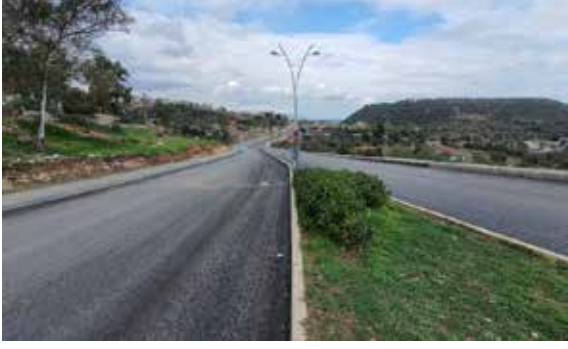
Karaburun Merkez Mahallesi Asfalt Serim Çalışması
