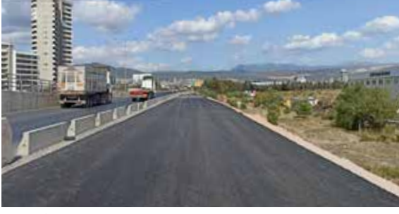
Bornova İlçesi Viyadük Şantiyesi Otopark Çıkışı Yan Yol Asfalt Serim Yapılması İşi
