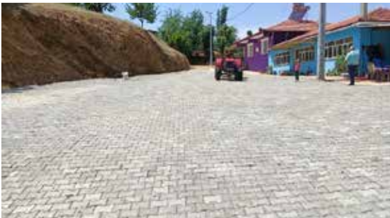
Kiraz Örencik Mahallesi Kilit Parke İmalatı Çalışması
