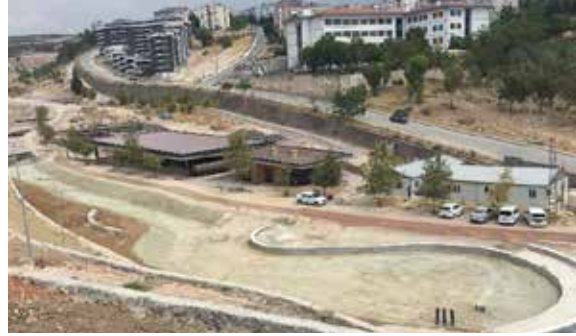
Portakal Vadisi Kafeterya, Hizmet Binaları ve Diğer Mimari Yapılar
