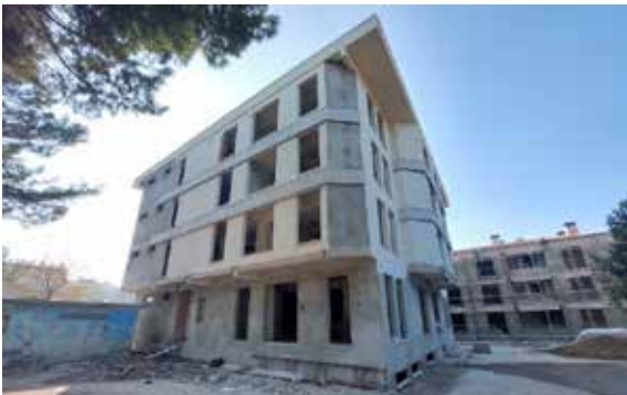
Gürçeşme Huzurevi ve Çocuk Meclisi Güçlendirme Tadilatı
