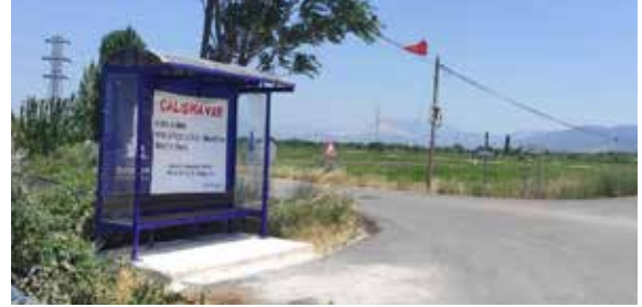
Bergama İlçesi Dağistan Mahallesi Kapalı Durak Montaj Çalışması
