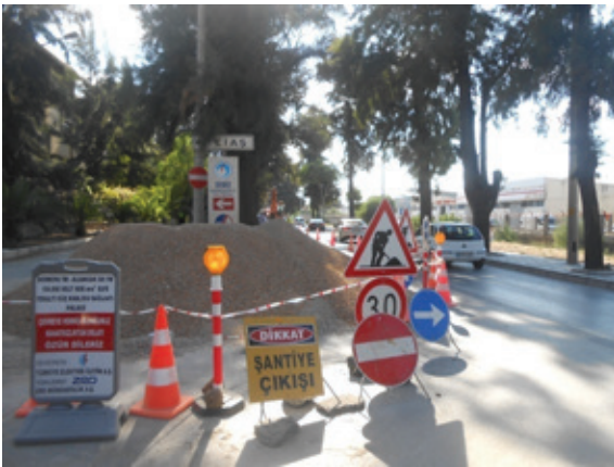
Bornova – Alsancak Hattı (Ağaçlı Yol) Yeraltı Güç Kablosu Bağlantı Çalışması
