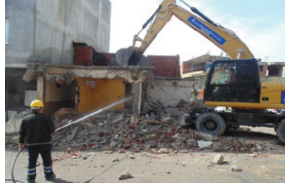
Uzundere Kentsel Dönüşüm Alanı Yıkım Çalışmaları
