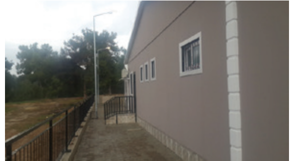
Ayrancılar Yenikent Mezarlığı Cenaze Yıkama ileDefin Hizmetleri ve Mescit Binası
