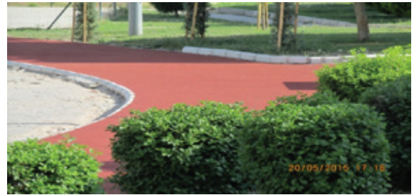
Karabağlar İlçesi Olimpiyat Köyü Zemin Yenileme Çalışması
