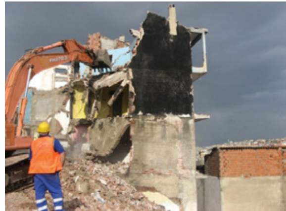
Yeşildere Heyelan Bölgesi'ndeki Yıkım Çalışmalarından Görünüm
