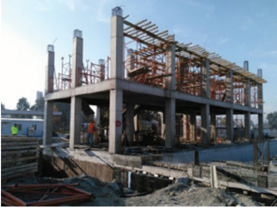
Halkapınar Atölye Binası
