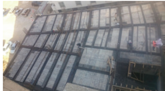
Oğuzlar Mah. 7530 Ada, 11 Parsel Belediye Hizmet Binası Yapımı
