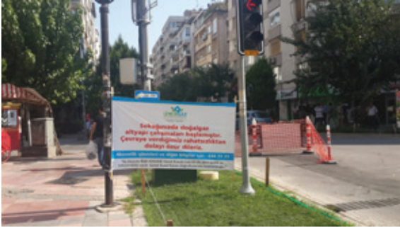
Konak Alsancak Plevne Bulvarı Doğalgaz Hattı Çalışması
