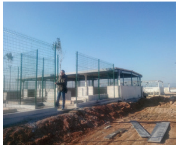
Hayvan Barınağı Yapılması
