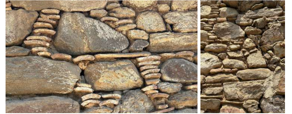
Fotoğraf 3.3. Yapı duvarı taş örgü detayları (Aliye Ahu Gülümser arşivi. 2025)
