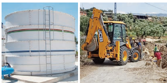
hattı 120 haneye hizmet edecek. Tire Derebaşı Mahallesi'nin su sorunu da 32 kilometrelik
