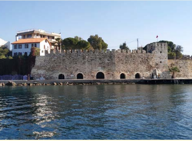
Kybele Kutsal Alanı üstünde yer alan Ceneviz kent duvarlarının restorasyonu sırasındaki görünümü.
