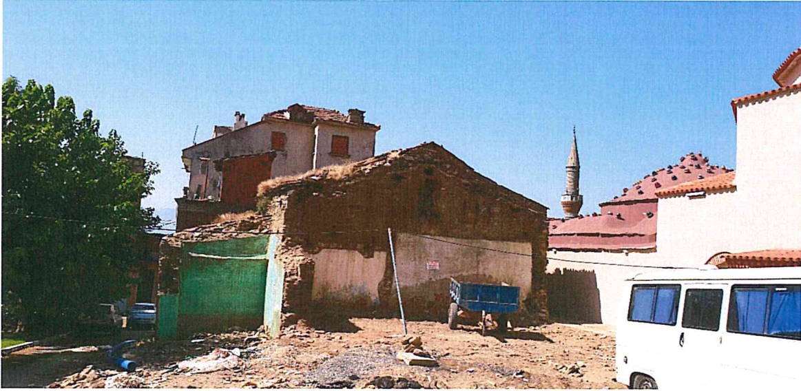
Cami Mahallesi 21 ada 7 parselde kayıtlı yapı
