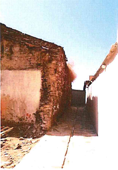
Hamamı yapısı ile yapının doğu beden duvarı arasına oluşan geçit.
